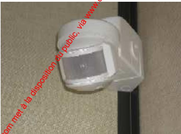
Montage en angle pour détection complète de la pièce.
