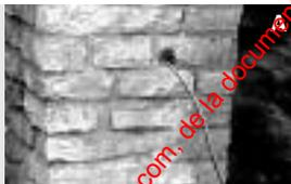
**B** - Le câble contourne le pilier : percer l'un des opercules à l'aide d'une lime queue de rat ou d'une pince coupante.
