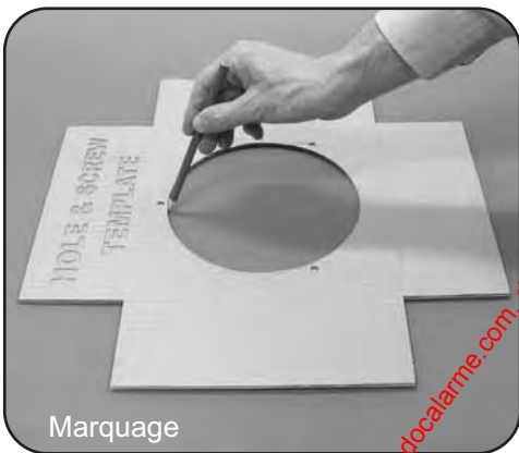
Fig.1 Gabarit de montage
